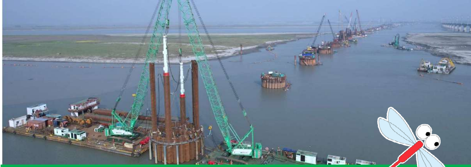
バングラデシュ ジャムナ鉄道橋 鋼管矢板井筒基礎打設風景
